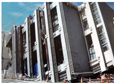
マンションの倒壊
